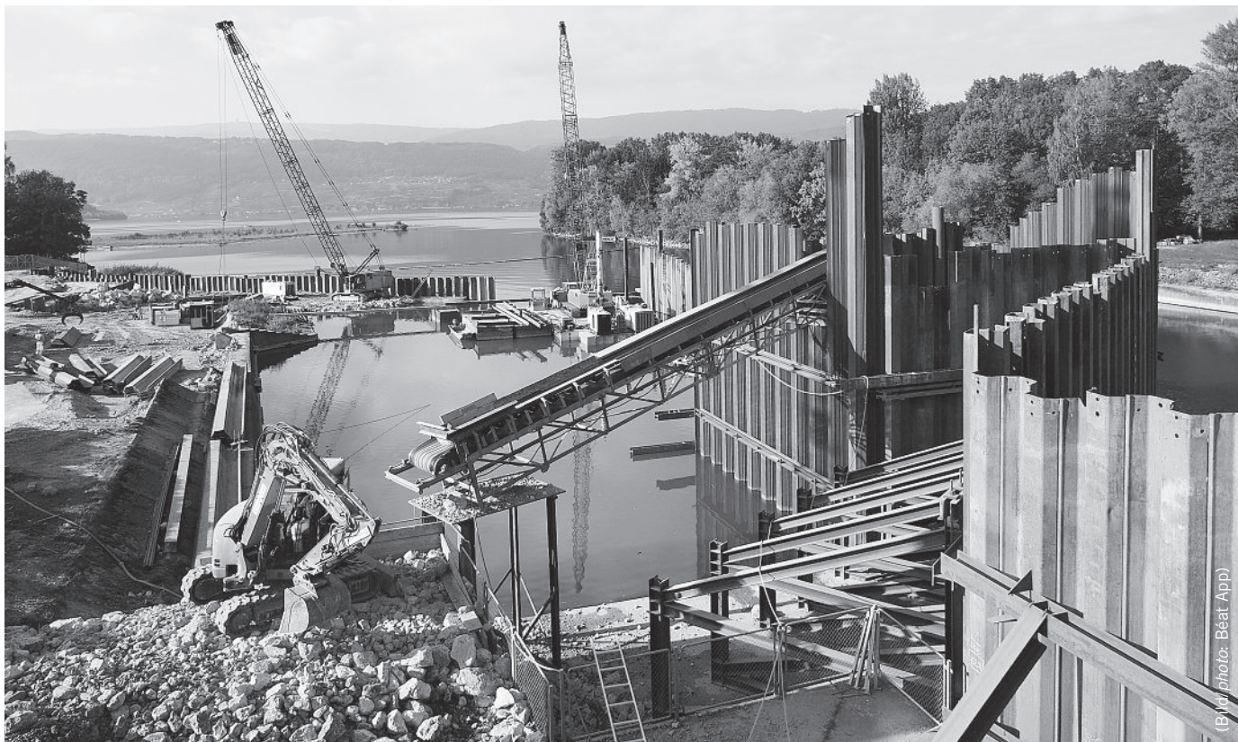
Bau des neuen Flusskraftwerks bei Hagneck: Zurzeit ist dies wohl eine der spannendsten Baustellen im Seeland. Construction d'une nouvelle centrale hydraulique à Hagneck: un des chantiers les plus captivants du Seeland.
