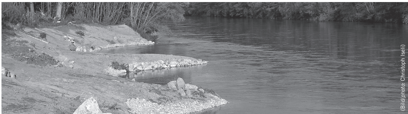
Neu geschaffene Buchten bieten auch bei Hochwasser strömungsarme Ruhezeiten für Fische. De nouvelles anses permettent aux poissons de s'abriter des courants même en cas de crues.
