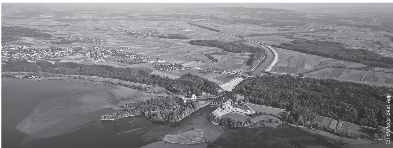
Ein Blick auf die Grossbaustelle Hagneckkanal aus der Vogelperspektive. Vue aérienne de l'imposant chantier en cours au canal de Hagneck.
