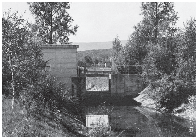
Zahlreiche Pumpwerke unterstützen im Raum Ins-Gampelen-Gals ein ausgeklügeltes Ent- und Bewässerungssystem. Im Bild das Pumpwerk Reuschelz mit angebautem Wehr, aufgenommen um ca. 1980.
