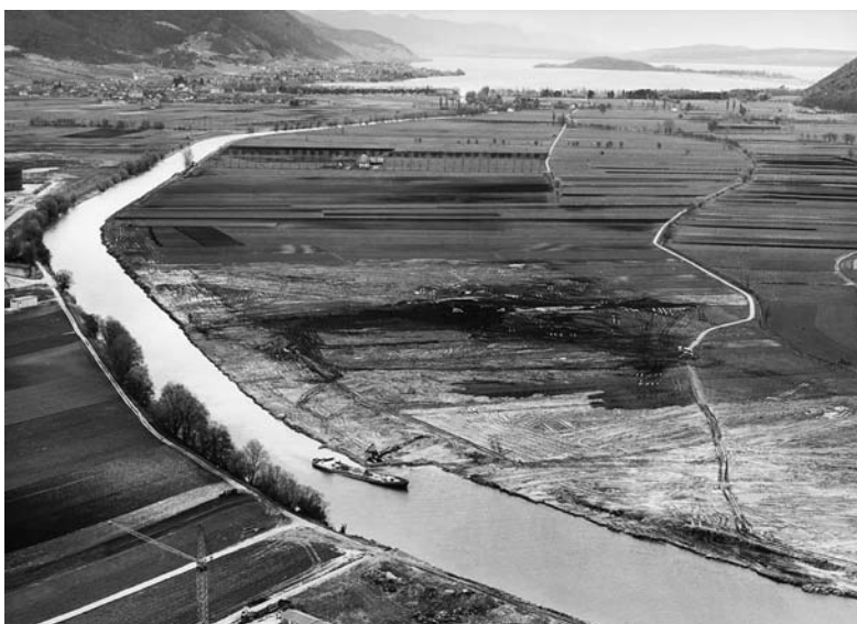
Während der JGK (1962–1973): Der Zihl-Kanal zwischen Neuenburger- und Bielersee wird ausgebaut.
