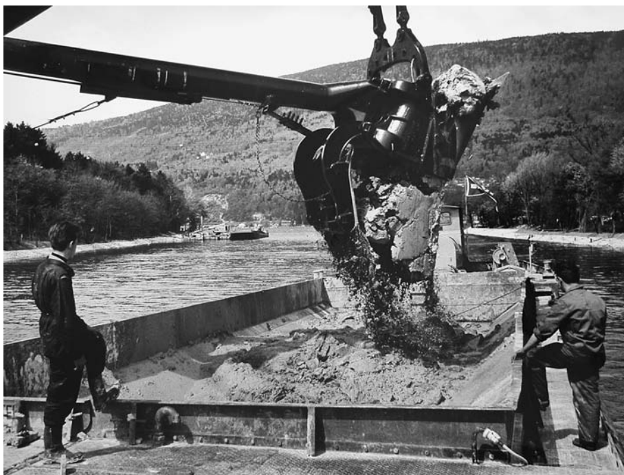
Aushubarbeiten im Nidau-Büren-Kanal während der zweiten JGK (1962–1973). Travaux d'approfondissement du canal Nidau-Büren pendant la 2 e CEJ.
