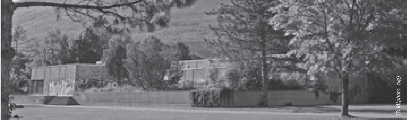
Mit dem 1975 erfolgten Bau des Seewasserwerks in Ipsach wurde der Bielersee zum wichtigsten Trinkwasserlieferanten des ESB. Après la construction de la station de pompage à Ipsach en 1975, le lac de Bière est devenu le principal fournisseur d'eau potable d'ESB.
